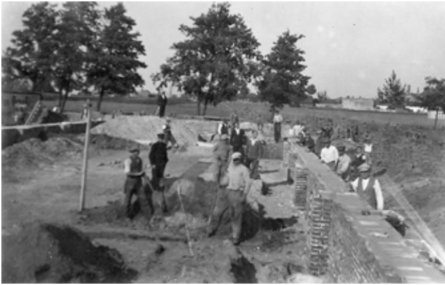
Budowa sali gimnastycznej o nazwie „Sokolnia”, ze zbiorów Socjum Kępno i Okolice (www.kepnosocjum.pl)
