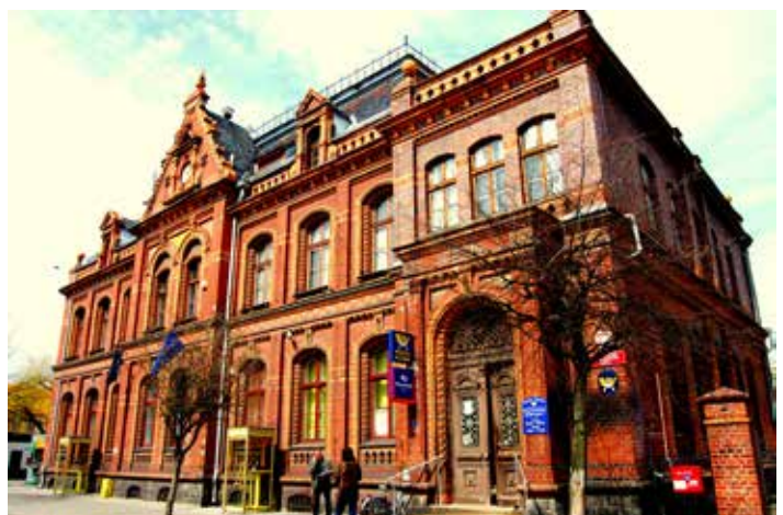
Budynek poczty w Kępnie, ze zbiorów Gminy Kępno
