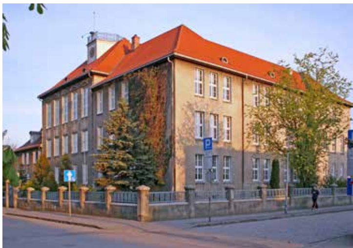
Budynek Gimnazjum przy ulicy Dąbrowskiego wybudowany w 1912 r., ze zbiorów Foto Adamski Kępno
