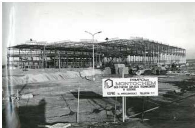
Zakład Urządzeń Chemicznych „Montochem” w budowie, ze zbiorów Gminy Kępno
