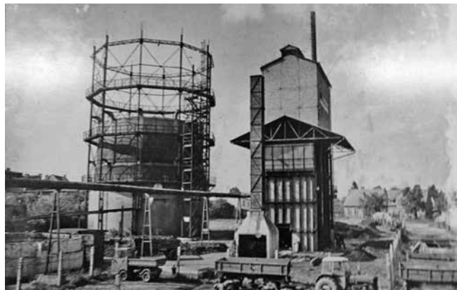
Rozdzielnia gazu w Kępnie, ze zbiorów Socjum Kępno i Okolice ( www.kepnosocjum.pl )
