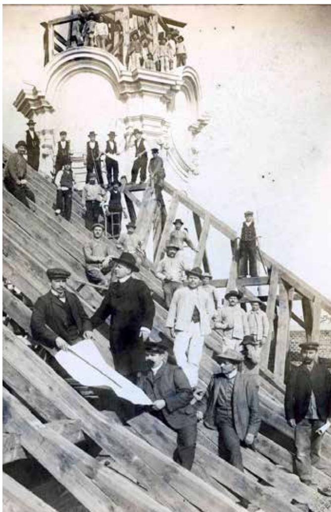
Budowa kościoła św. Marcina w Kępnie – R. Stawski tłumaczy księdzu I. Nowackiemu oraz robotnikom zasady projektu kościoła, ze zbiorów Socjum Kępno i Okolice (www.kepnosocjum.pl)
