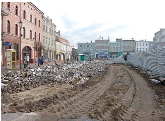
Kępiński Rynek podczas remontu, styczeń 2008 roku.
