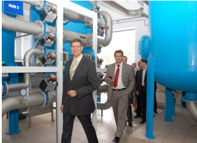
Otwarcie Stacji Uzdatniania Wody w Kępnie, kwiecień 2008 r.
