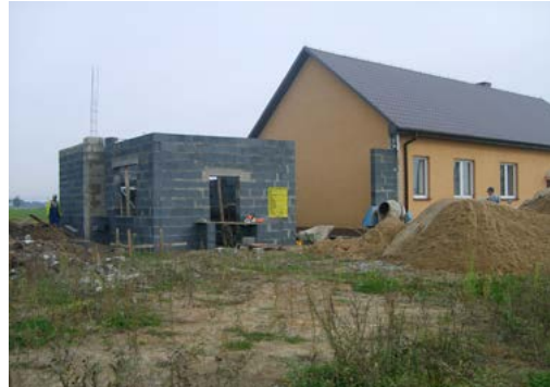
Budowa nowej remizy – 2014 r.
