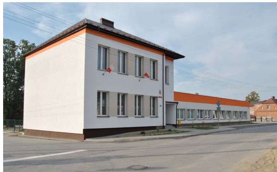
Rozbudowa Szkoły Podstawowej w Świbie.
