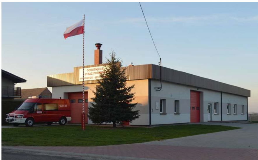
Rozbudowana remiza OSP Myjomice-Ostrowiec.
